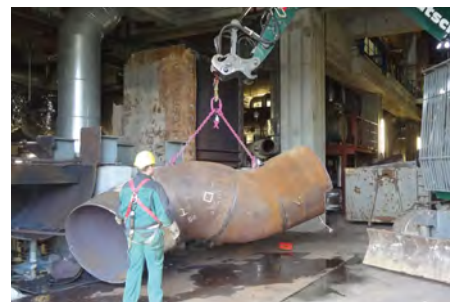
Rückbauten, Umbau- und Entkernungsarbeiten
