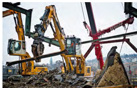
Abbrüche: Stahlträgerkonstruktionen, z. B. Stuttgart 21 Bahnhof, Hallenkonstruktionen, Kranbauten, Silos etc.
