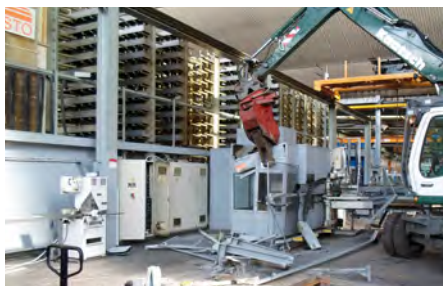
Rückbauten: z. B. Lagersysteme, komplette Produktionsanlagen, Peripherie, Transportsysteme etc.
