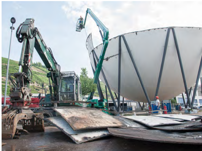
2016 Demontage Gaskugelspeicher Stadtwerke Esslingen
